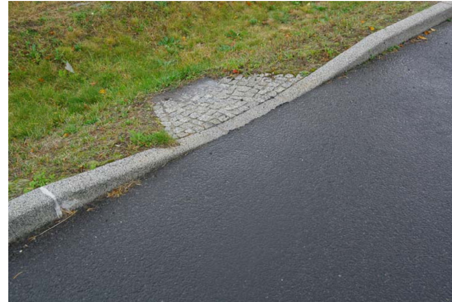
Kuva 6. Esimerkki reunakiven aukosta
